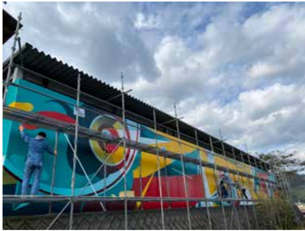
制作期間中 Works in progress
